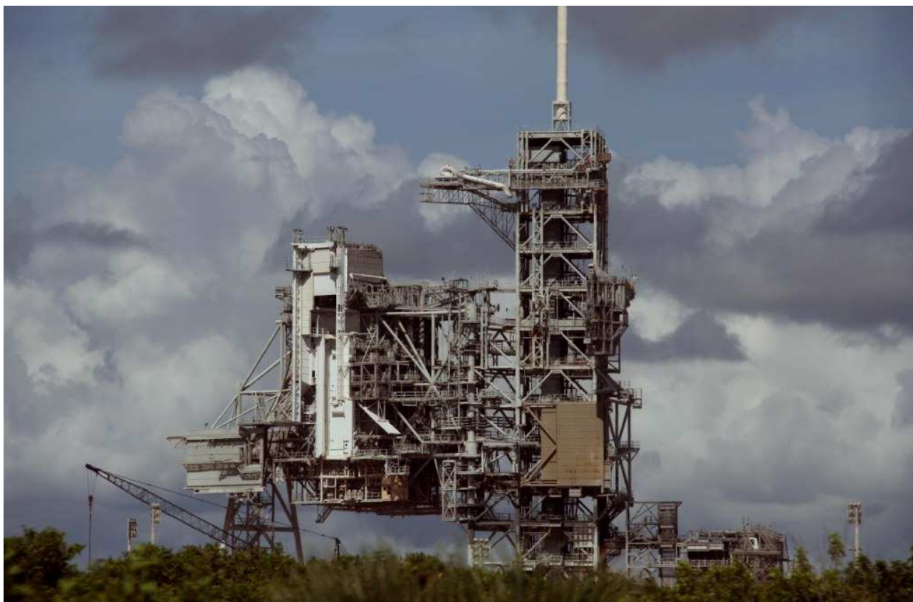
Launch Pad 39A. Da questa rampa di lancio sono partite la maggioranza delle missioni Apollo, compresa la 11. Successivamente, come appare nell'immagine, è stata riconvertita per il programma Shuttle e in futuro verrà usata per altre missioni spaziali.
