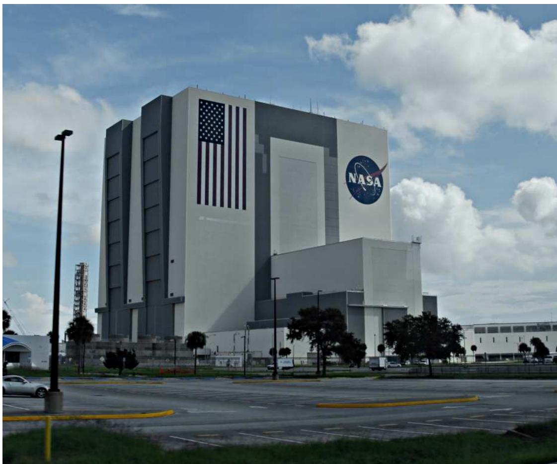
VAB (Vehicle Assembly Building). Originariamente costruito per le missioni Apollo è stato successivamente riadattato per il programma Shuttle. La sua altezza è di 160 metri.
