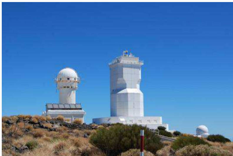
A sinistra, il telescopio solare THEMIS da 90 cm; a destra, la torre VTT con strumento da 70 cm ( f/66 ) in camera a vuoto con eliostato superiore
