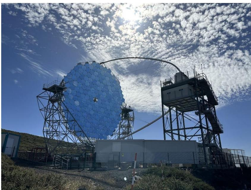
Il telescopio Lst-1, con il suo specchio primario composto da 400 metri quadrati d’area di raccolta, si erge all’Osservatorio Roque de los Muchachos dell’Instituto de Astrofísica de Canarias (iac), sull’isola di La Palma, alle Canarie (Spagna).
