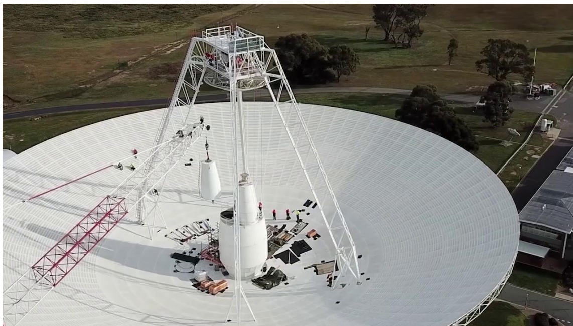
L'antenna radio Deep Space Station 43 a Canberra, in Australia durante aggiornamenti e riparazioni: uno dei coni di alimentazione bianchi dell'antenna (che ospitano parti dei ricevitori dell'antenna) viene spostato da una gru. Crediti: CSIRO
